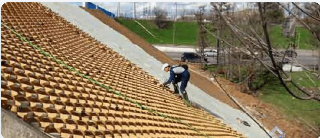
پر کردن سلولهای ژئوسل با مصالح
