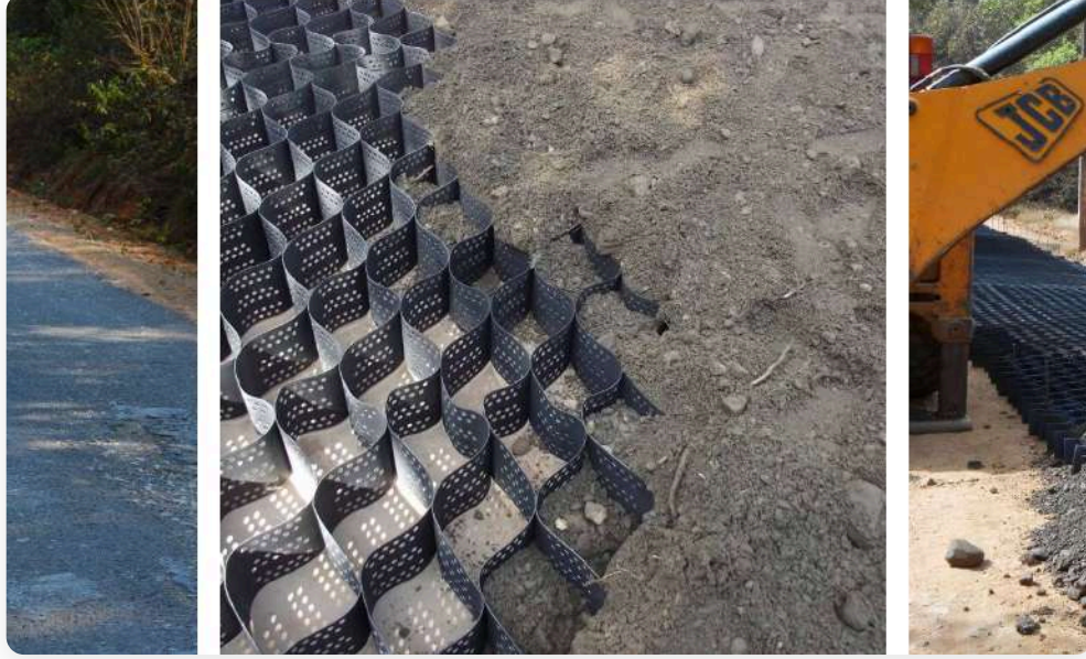
مشروع إعادة بناء طريق باستخدام الجيوسيل
