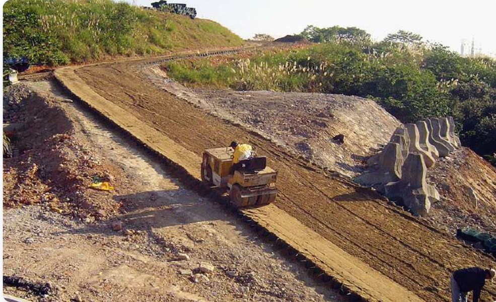
مشروع إعادة بناء طريق باستخدام الجيوسيل
