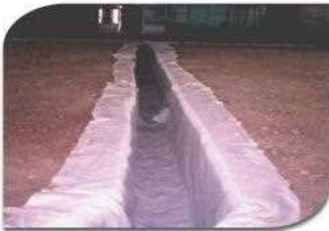
أعمال الصرف الصحي وتركيب أنابيب UPVC
