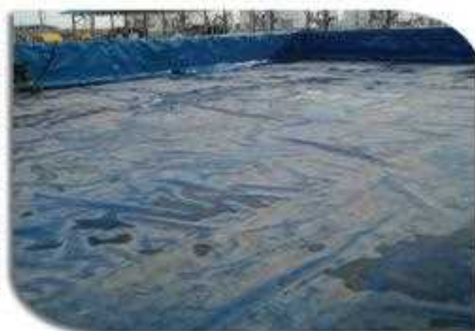
حوض تخزين مياه لإطفاء الحرائق
