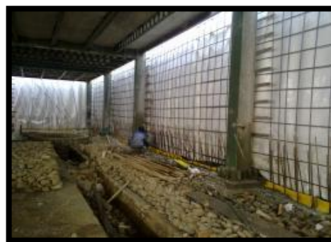
ایزولاسیون و زهکشی گود ساختمان مسکونی پروژه خیابان یاسر
