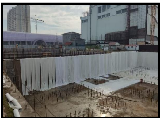
ایزولاسیون و زهکشی گود ساختمان بندر انزلی
