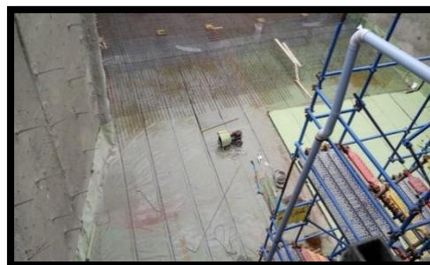
ایزولاسیون و زهکشی گود ساختمان مسکونی پروژه سپر
