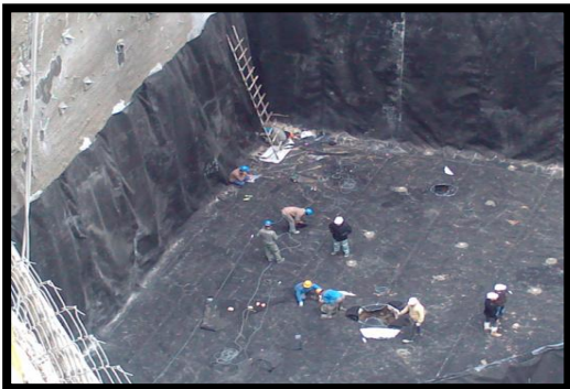
آب بندی گود ساختمانی شرکت کیا بتن
