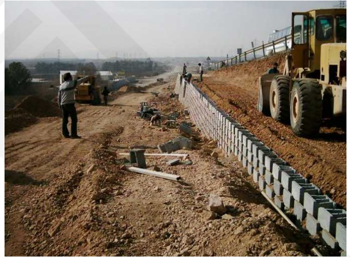
اجرای همزمان عملیات خاکی و چیدن بلوکها
