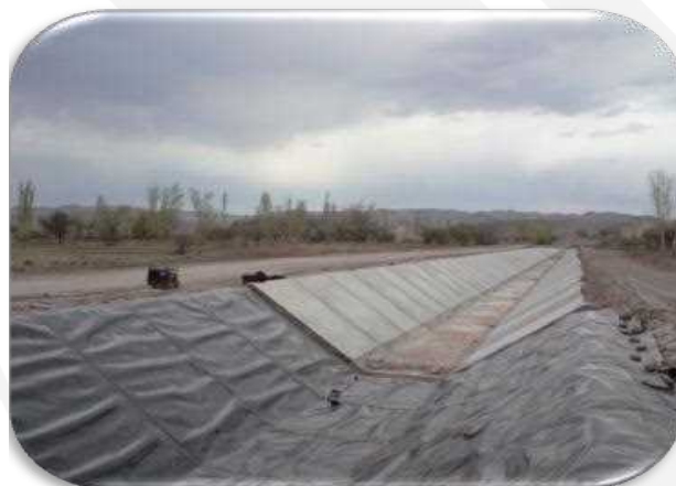
ساخت و عایقکاری کانال های انتقال آب
