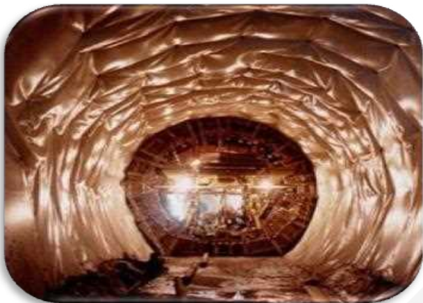
عایقکاری تونل ها
