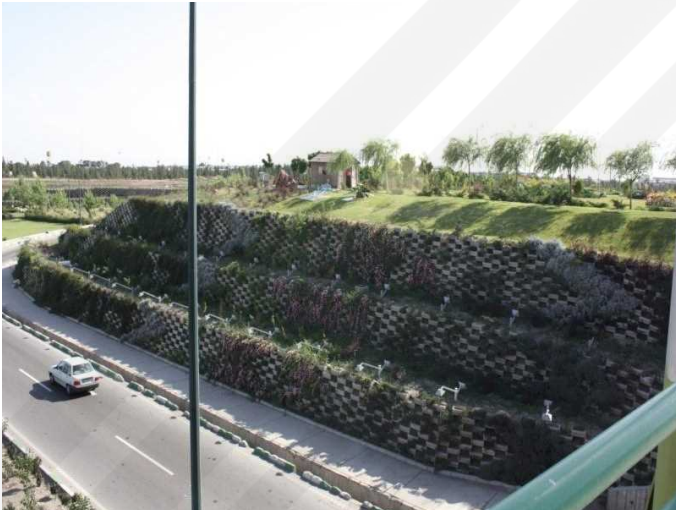
دیوار حائل بزرگراه آزادگان
