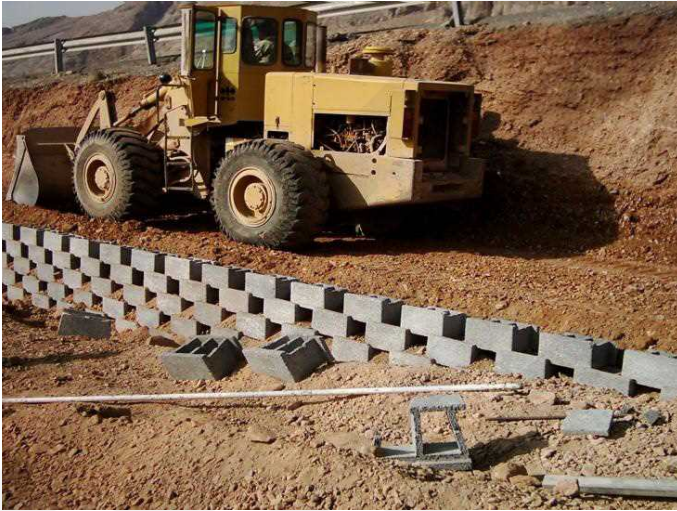
اجرای همزمان عملیات خاکی و چیدن بلوکها
