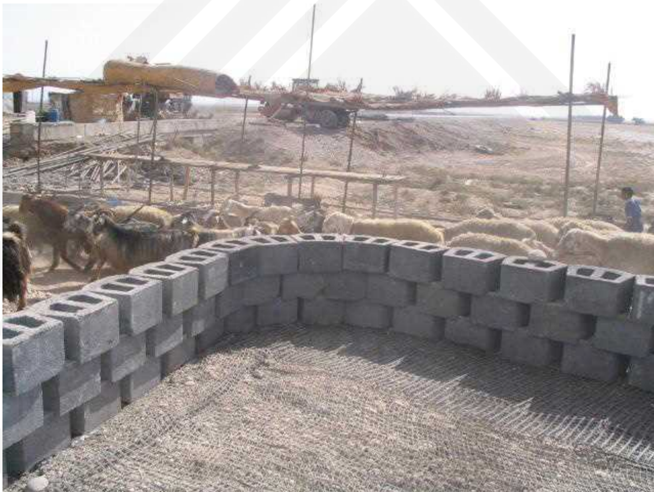
عملیات بلوک چینی
