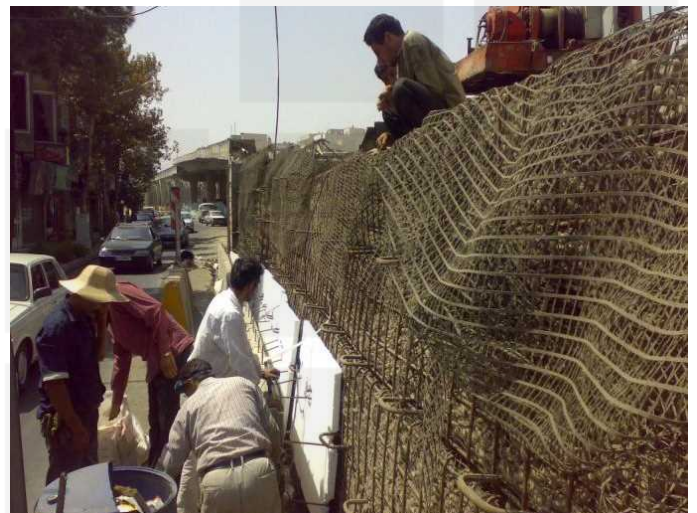
اجرای پل بتنی
